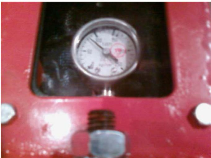
**Показания манометра сработавшей системы АСВП-ЛВ №06-727 – стрелка занимает произвольное положение ( $90 \text{ кг/см}^2$ )**
