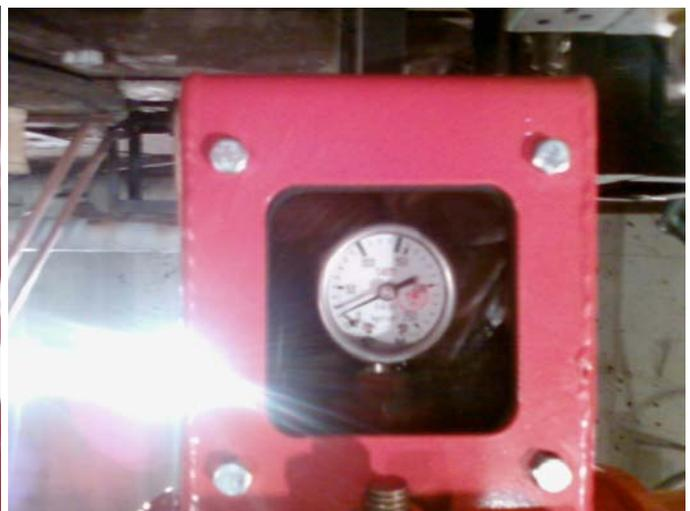
**Показания манометра сработавшей системы АСВП-ЛВ №06-729 – стрелка занимает произвольное положение ( $25 \text{ кг/см}^2$ )**
