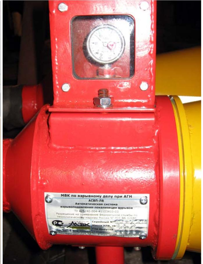
**Показания манометра сработавшей системы АСВП-ЛВ №06-728 – стрелка занимает произвольное положение ( $80 \text{ кг/см}^2$ )**
